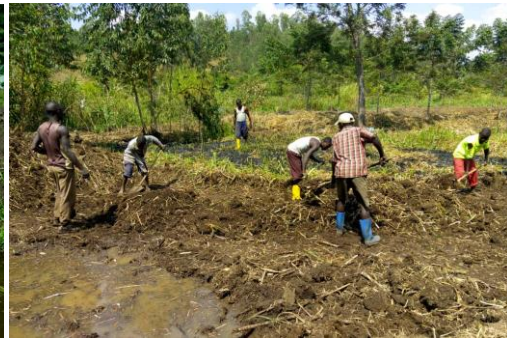
Umweltequipe beim Aushub des zweiten Teiches
