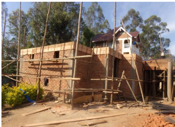
Fotos: li Mehrzweckgebäude im Bau
